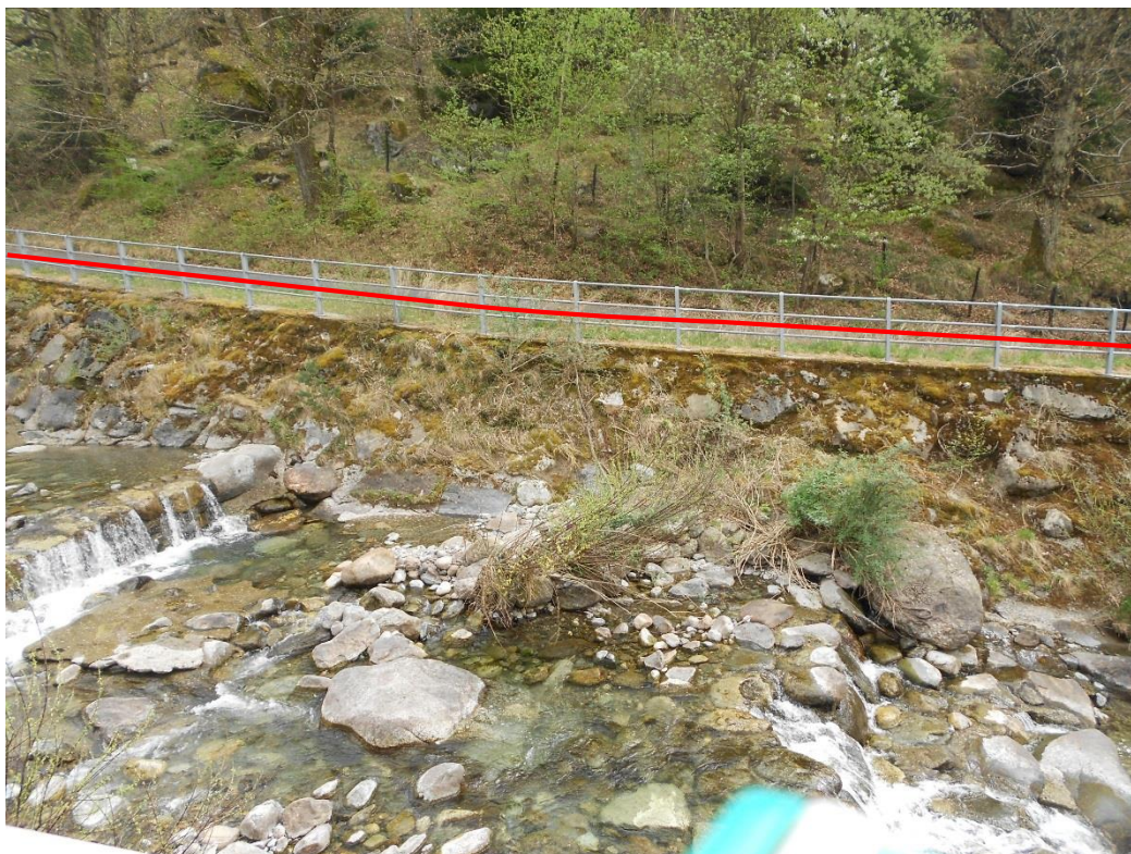
Figura 3 – Zona di passaggio condotta forzata
