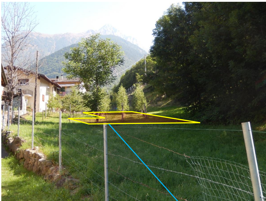
Figura 15 – Zona di realizzazione edificio centrale
