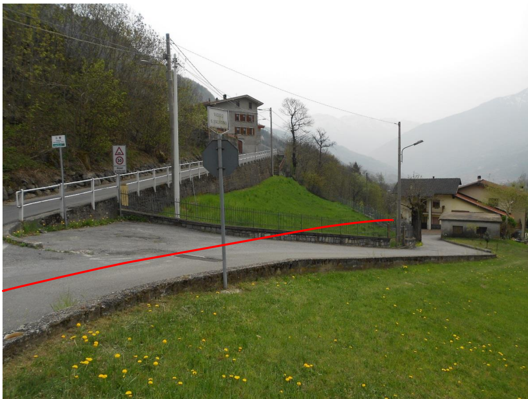
Figura 9 – Zona di passaggio condotta forzata
