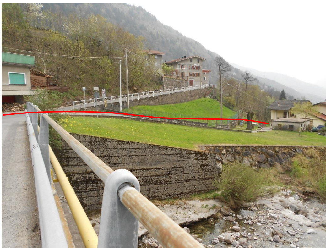
Figura 8 – Zona di passaggio condotta forzata
