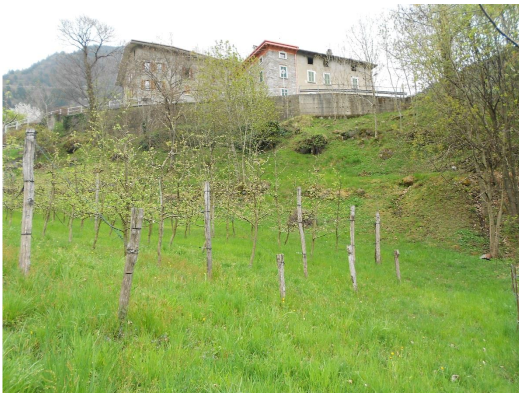
Figura 14 – Zona di realizzazione edificio centrale
