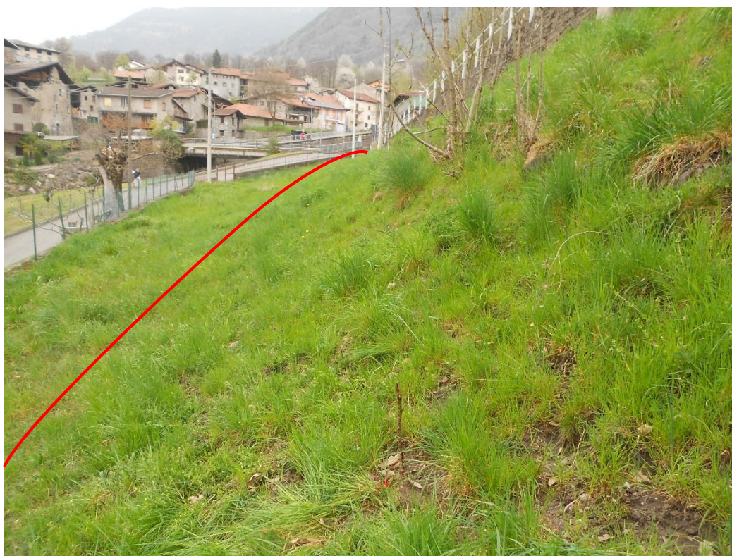
Figura 10 – Zona di passaggio condotta forzata
