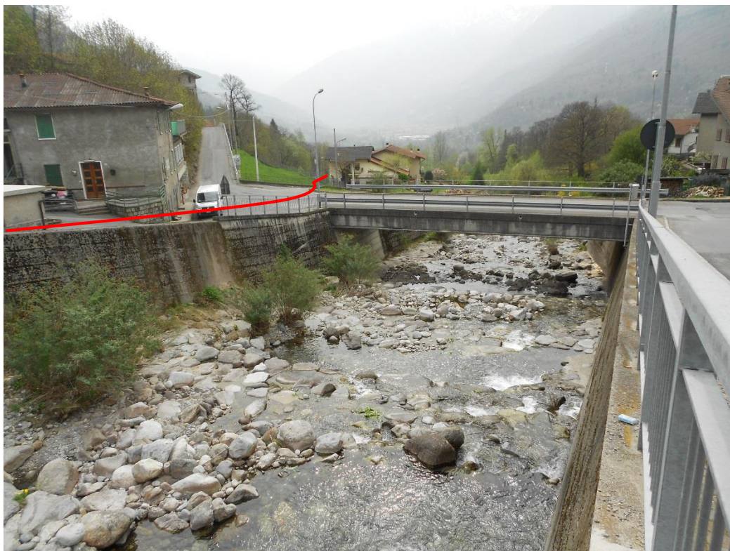
Figura 5 – Zona di passaggio condotta forzata
