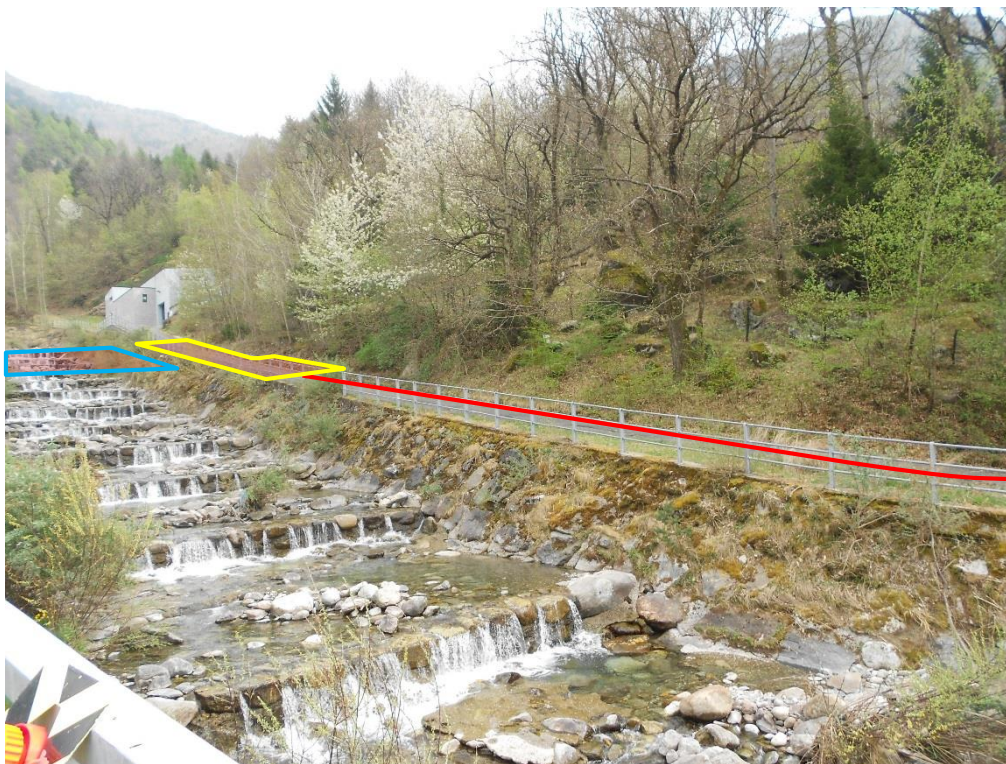
Figura 2 - Vista zona di realizzazione dell'opera di presa
