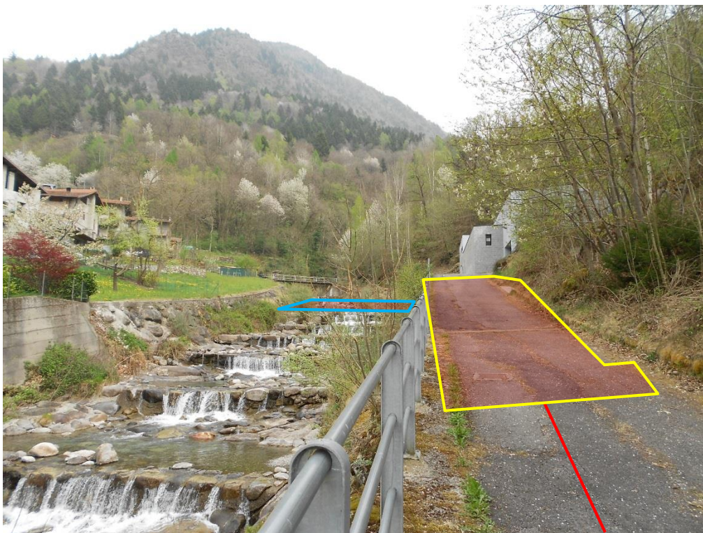
Figura 1 - Vista zona di realizzazione dell'opera di presa
