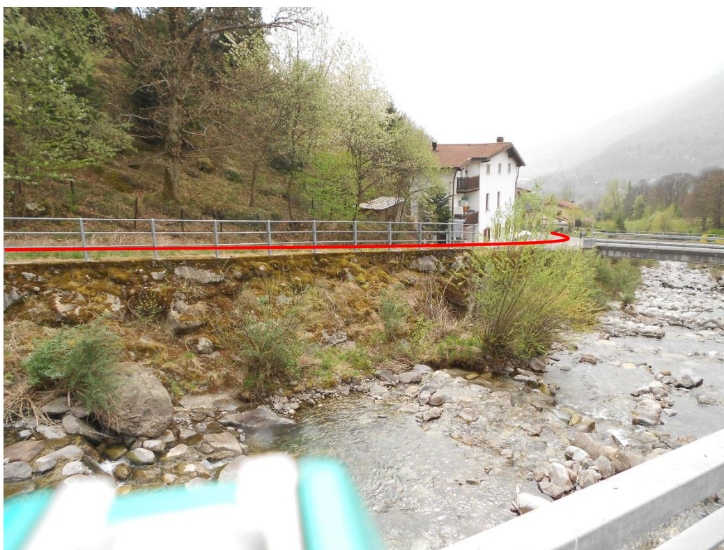
Figura 4 – Zona di passaggio condotta forzata
