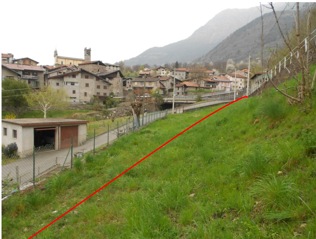
Figura 11 – Zona di passaggio condotta forzata
